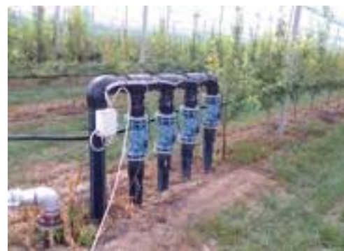
Elettrovalvole di grande diametro in ghisa alimentate a corrente continua.
